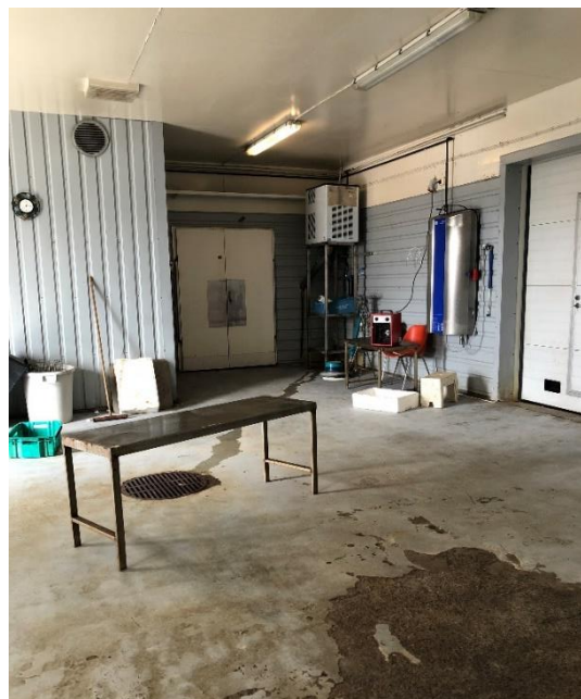
Kuvat 2 ja 3. Kalankäsittelyhallin betonilattian epoksilattiapinnoite on kulunut ja betoni halkeillut. Hallin valaistus on riittämätön ja se on toteutettu halogeeniputkivalaisimilla. Kalanperkuupöydät ovat ruostuneet ja huonokuntoiset. Nosto-ovet, ulko- ja sisäovet ovat uusimisen tarpeessa.
