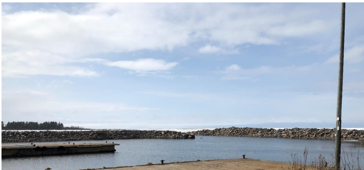
Kuva 4. Sataman sisääntuloväylä on madaltunut paikoin alle kahteen metriin. Laitureiden suojaustörmien puuttuminen aiheuttaa laiturirakenteiden vaurioitumista.
