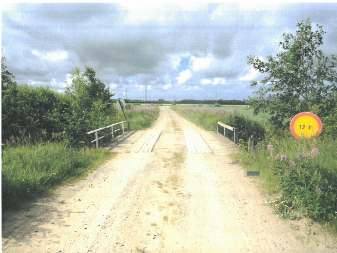
Kuva 1. Toukkalantien silta puretaan Toukokuussa 2020 ja korvataan siltarummulla. Toukkalantien pohjoispuolella sijaitseva Saukkolantie käytetään tuulivoimapuiston rakentamisessa tulotienä ja Toukkalantie toimii poistumistienä.
