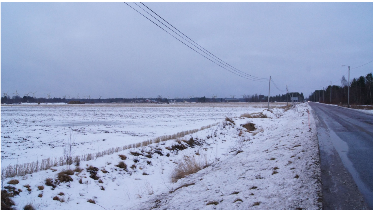
Kuva 1. Yppäristä kaakkoon. Etäisyys lähimpään voimalaan 5,6 km. 18 mm polttoväli. Puskakorven tuulipuiston suunnitteilla olevat voimalat näkyisivät kuvanottopisteeseen selkeästi, samoin kuin Karhunnevakankaan voimalat. Karhunnevakankaan tuulipuiston voimalat sijoittuvat osin toistensa taakse. Pyhäkosken ja Ristivedon voimalat eivät näy kuvanottopisteeseen.
