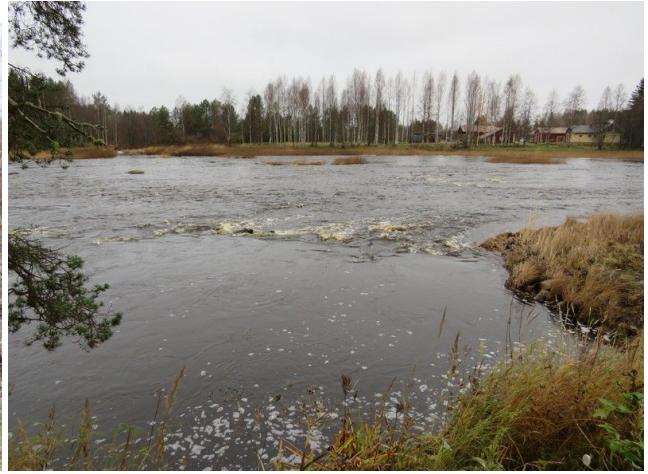
Johdinaiden länsipuolella erottuu vähäisiä pohjapadon jäänteitä, kuva pohjoiseen.
