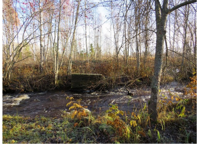
Betonipadon jäännös johdinaidan länsilaidalla, kuva itään.
