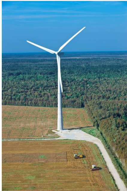
Kuvat 6-7. Kuva teräsbetonirakenteisesta tuulivoimalasta ja periaatekuva tuulivoimalasta (Lähde: Win-Wind Oy).
